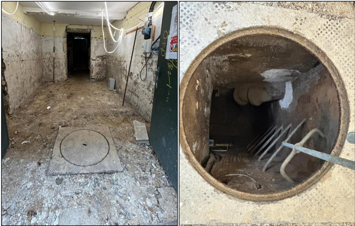
Figure 11 : Constat photographique de l'égout enterré au droit de l'entrée du bâtiment
