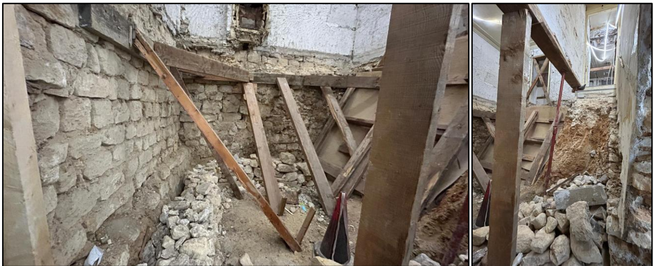
Figure 3 : Zone sur terre-plein côté rue terrassée et étagée provisoirement
